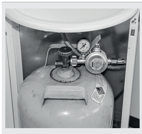
Abb.3: Installation der Gasflasche
